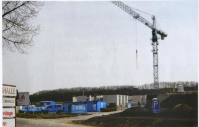
Die ersten Mauern für das Seniorenzentrum stehen.
