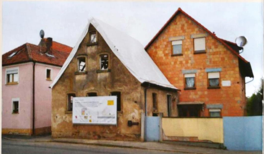
Brückentorstraße 14 - ein Objekt, das polarisiert. Einerseits neuer Wohnraum, andererseits hohe Kosten.
